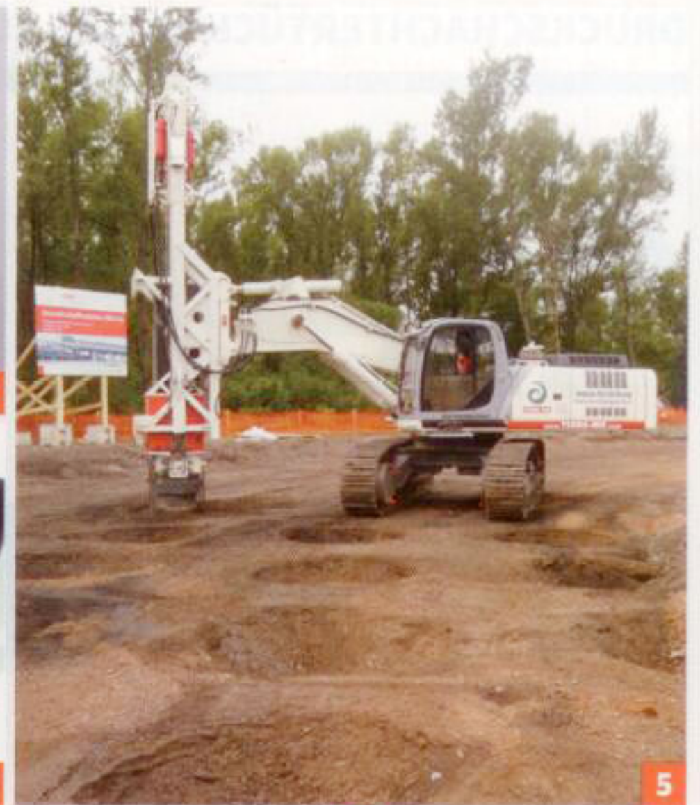
3 Entwickelter Spezialgegenballast mit dreigeteiltem Gewicht am Baggerheck 4 Für die Impuls-Verdichtung wurde ein eigenes Monitoringsystem entwickelt 5 Die Verdichtungsarbeit wird in einem bestimmten Raster mit ein bis drei Arbeitsübergängen durchgeführt
