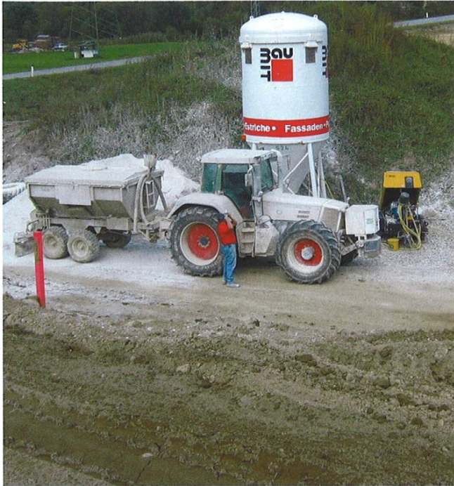
Baukalk für die Bodenverbesserung.
