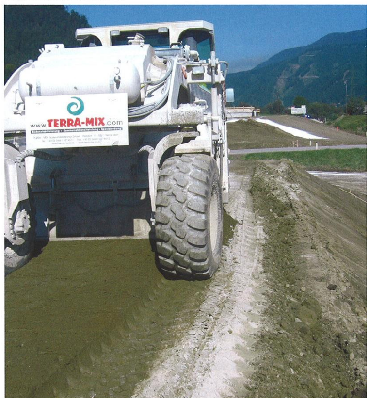
Aufstreuen und Einarbeiten von Bindemittel.
