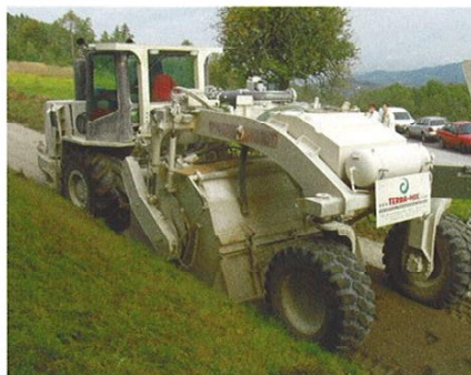
... und dem Asphaltbelag wurde ...
