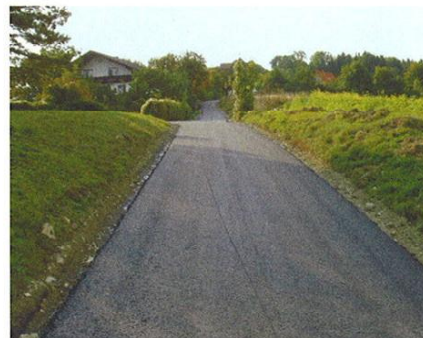
... eine neue frostsichere und rissefreie Tragschicht hergestellt.
