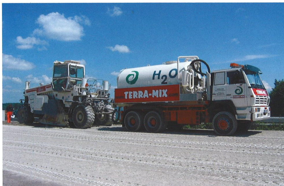
Verdichtung unter Zugabe von Wasser.
