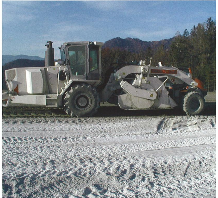
Aufstreuen und Einarbeiten von Bindemittel.
