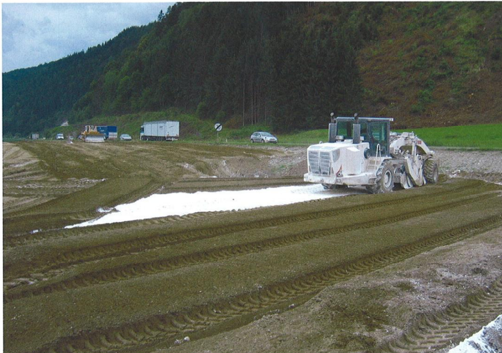
Bodenverfestigung mit Zugabe von Bindemittel.
