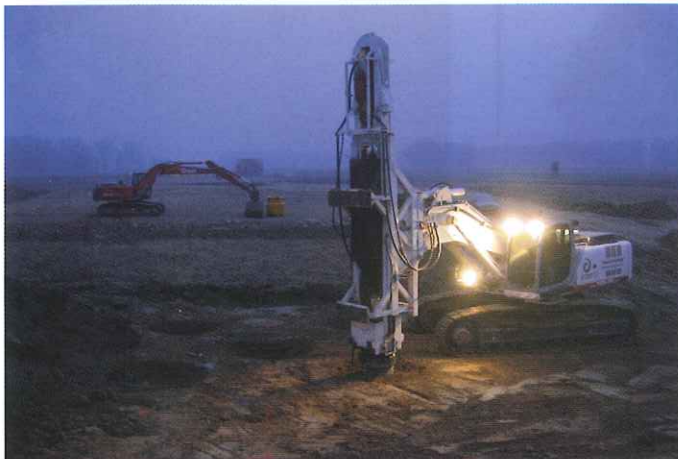
Abb. 1: Impulsverdichter im Einsatz
