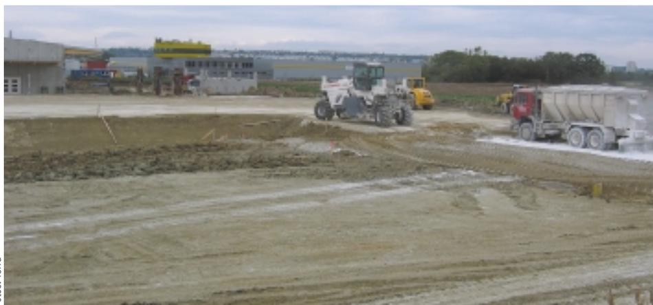
*Nach dem Einbau von DOROSOL C 100 wurde bei der Errichtung des Postverteilerzentrum Inzersdorf eine wesentlich bessere Tragfähigkeit erreicht.*
