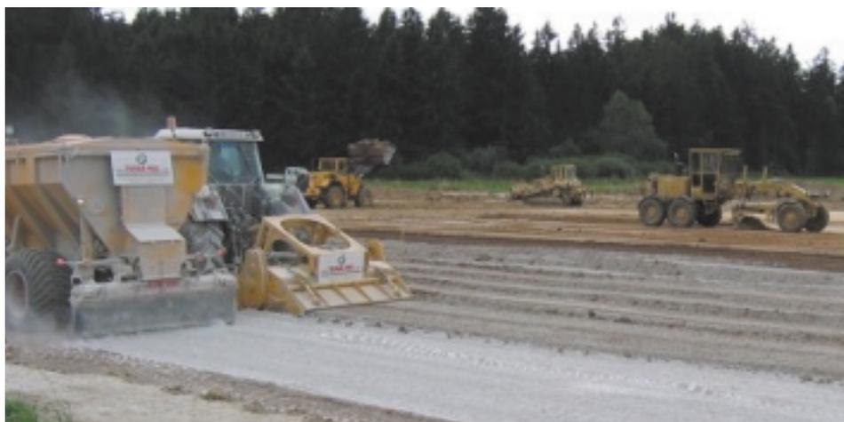
*Bei den vorbereitenden Bodenarbeiten für den Bau der Biogasanlage Echsenbach konnte mit DOROSOL C 50 eine massive Bodenverbesserung erreicht werden.*
