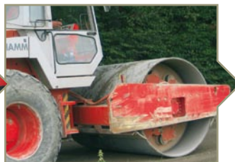
Verdichtung mit dem optimalen Wassergehalt für ein gutes (Verdichtungs-)Ergebnis
