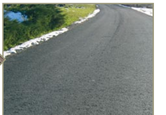
Fertigstellung der Straße durch Auftrag einer dünnen Verschleisschicht (z.B. 8cm Asphalt). - Dadurch ist der Vorgang extrem ressourcenschonend
