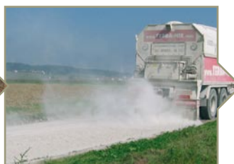
Aufstreuung der Bindemittelmischung
