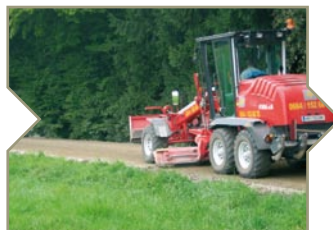
Herstellung einer asphaltierfertigen Fein-Planie
