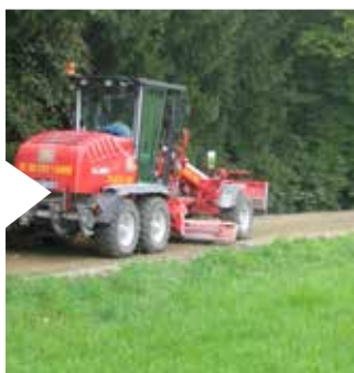
Realizarea unei suprafețe nivelate pentru aplicarea asfaltului
