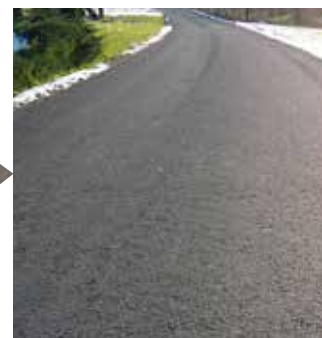
Finalizarea drumului prin acoperirea acestuia cu un strat de uzură subțire (de exemplu, asfalt de 8 cm, deoarece acest proces conduce la economisirea mare a resurselor).
