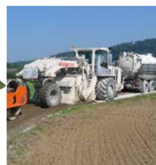
Amestecarea stratului portant vechi, a stratului superior, a apei și a liantului pentru reciclarea drumului în vederea creării unui strat portant nou de calitate înaltă
